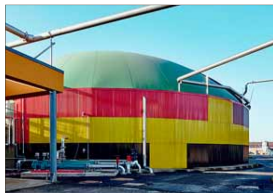
Depósitos que transforman excrementos en energía. M.D.M.
